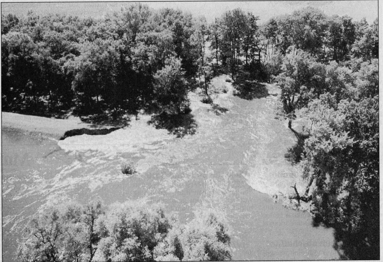
Riesige Wassermassen strömten durch den gebrochenen Deich bei Brieskow-Finkenheerd an der Oder südlich von Frankfurt in das Landesinnere. Der Deich hielt dem Druck der Wassermassen des Grenzflusses nicht mehr stand und brach auf 115 Meter Länge ein. Foto: DPA
